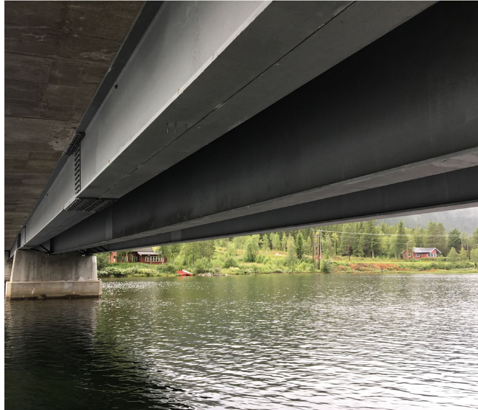
Seimsbrua, Hol kommune
