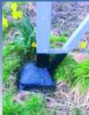
Master nær kysten. Mastefot og betongelementet er godt beskyttet for å hindre inntrenging av saltvann.
