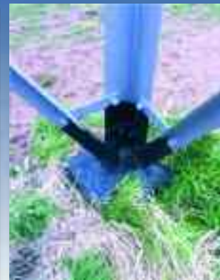
Master nær kysten. Mastefot og betongelementet er godt beskyttet for å hindre inntrenging av saltvann.
