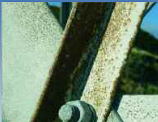
Den originale galvaniseringen er snart slutt og strukturen er dermed kommet inn i en kritisk fase.
