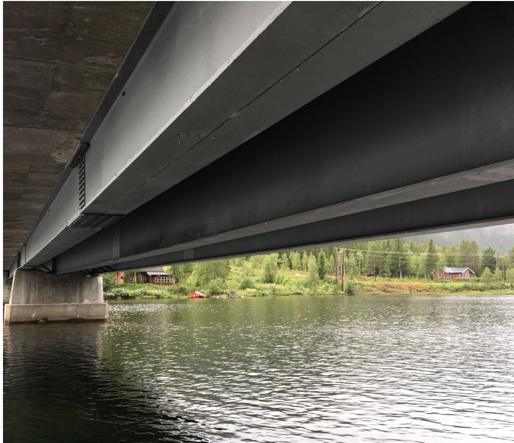
Seimsbrua, Hol kommune
