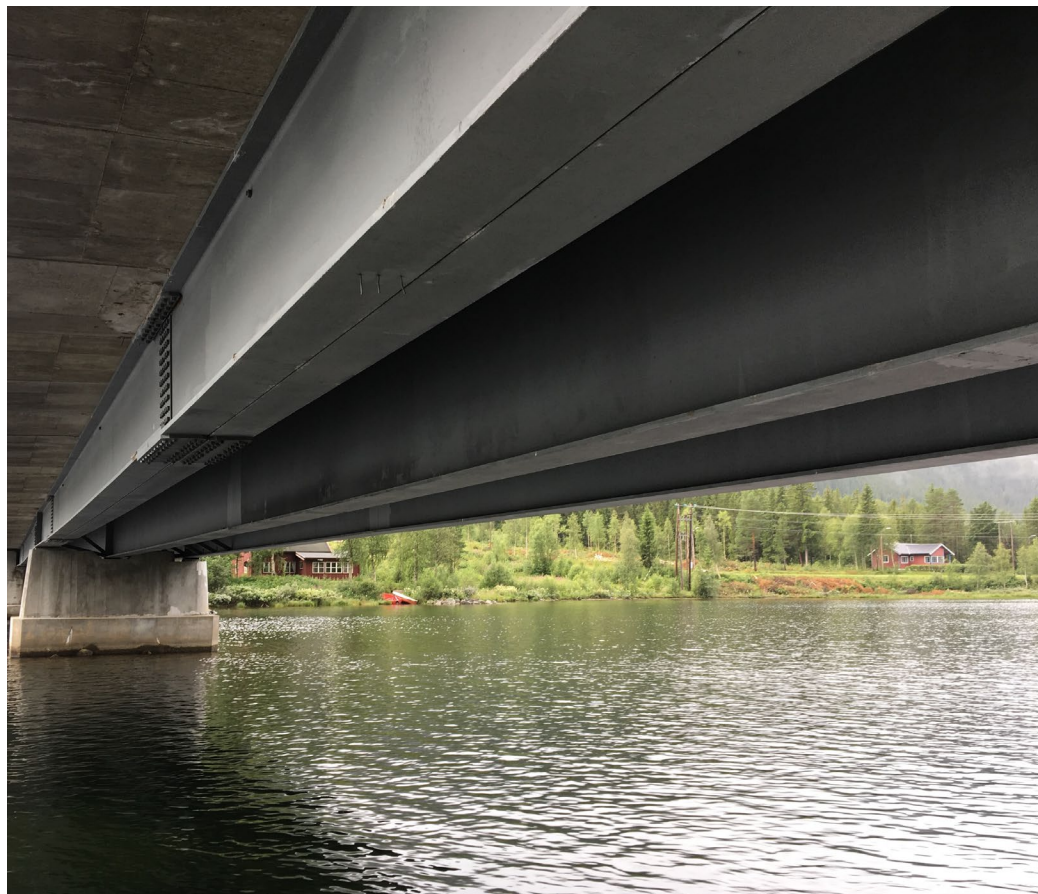
Seimsbrua, Hol kommune
