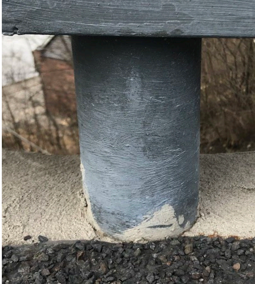
Sandesund bru, Sarpsborg
