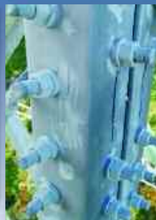
Lokale reparasjoner. Rustne bolter er regalvanisert med to strøk ZINGA flytende galvanisering.
