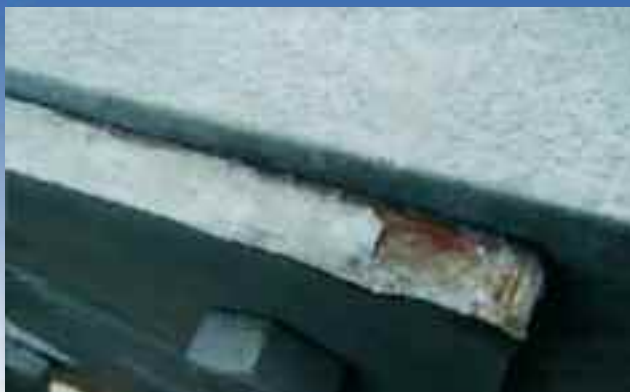
Ved transport og montering oppstår det ofte skader på varmgalvanisering. Det er viktig at disse områdene blir reparert med ny galvanisering.
