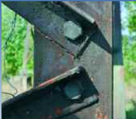
Rehabilitering med malingsprodukter vil ikke vare og er kun en utsettelse av nødvendig regalvanisering.
